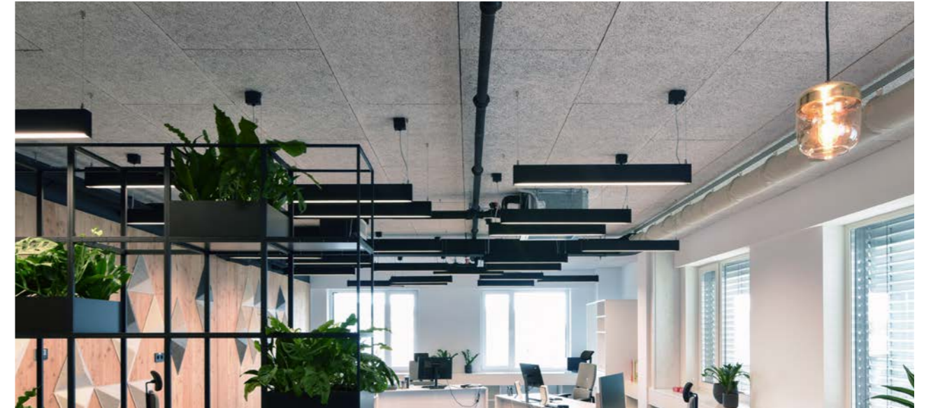
Metallunterkonstruktion, P5 Kante, 25mm CEWOOD Akustikplatte
